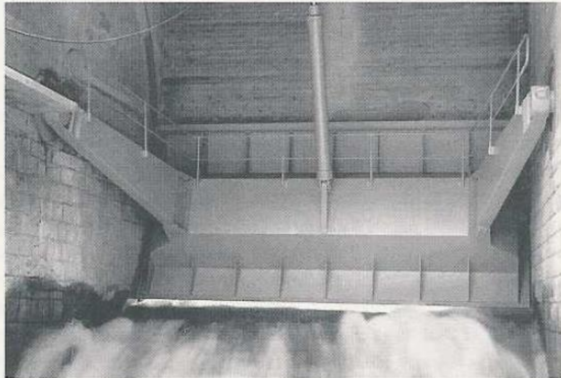
Fig. 2.53 Bottom outlet segment gate, Innerferrera Dam (ZWAG)
