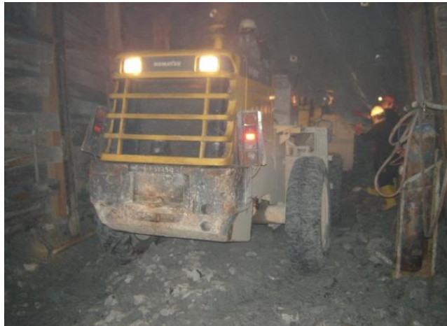
Pemasangan penyangga dengan bantuan Wheel Loader (56 kW)
